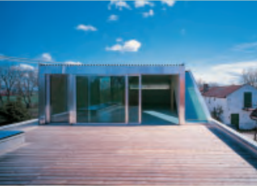
Das Architektenteam ARTEC wurde 1998 für den Umbau eines Bauernhauses im niederösterreichischen Raasdorf mit dem Aluminium-Architektur-Preis ausgezeichnet. © Margherita Spiluttini
